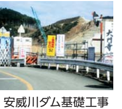
安威川ダム基礎工事
